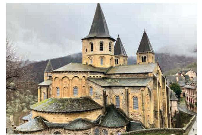
Photographie du chevet avant travaux, 2023. © M+O.
