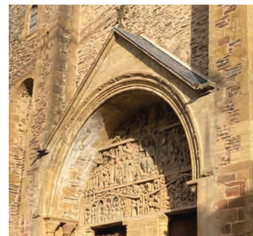
Photographie du tympan occidental après réfection de sa couverture, 2021. © M+O.
