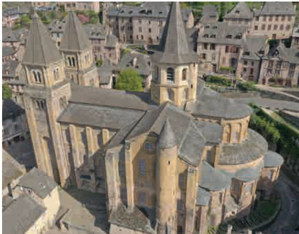
Vue d'ensemble de l'abbatiale avec son chevet rayonnant et échelonné, 2020. © Drone Aveyron Services.
