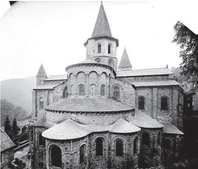
Le chevet de l'abbatiale, après les travaux de Henri NODET. Photographie anonyme, vers 1928. © MPP.
