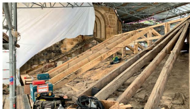
4- Toiture du chœur : remplacement à l'identique des bois de charpente dégradés.
