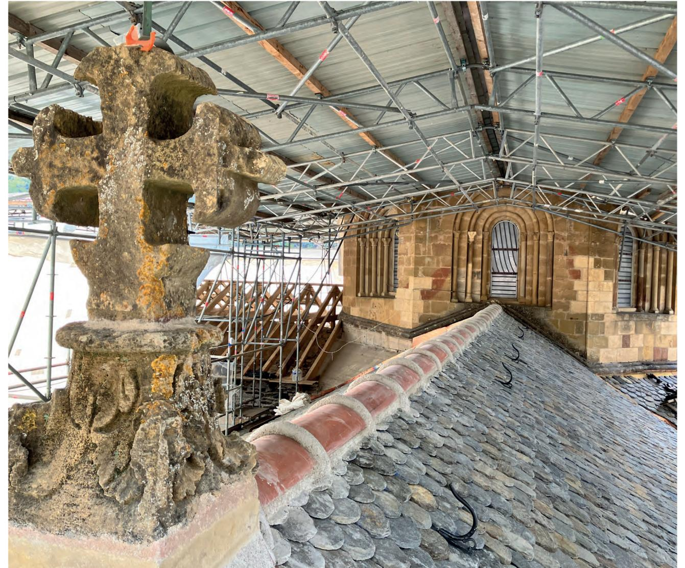
La toiture du vaisseau principal du bras nord du transept après restauration de la charpente et réfection à neuf de la couverture en lauzes de schiste.
