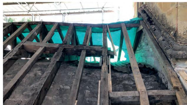
Charpente du bras nord du transept après dépose de la couverture : fermes affaissées, bois dégradés.
