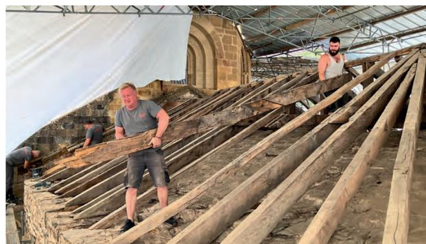
3- Toiture du chœur : dépose des bois de charpente dégradés.
