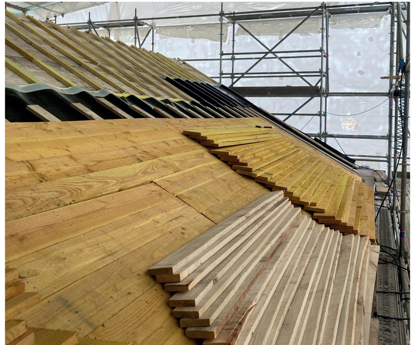
Toiture du vaisseau principal du bras nord du transept : pose du complexe de « climat de montagne » avec double volige, étanchéité et lame d'air.
