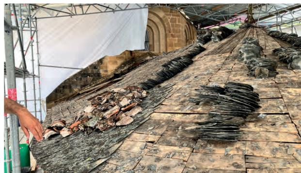
2- Toiture du chœur : dépose de la couverture en ardoise.
