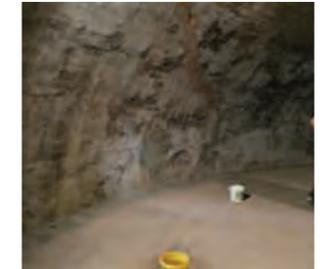
Fracture de la voûte et infiltrations au niveau de la galerie haute du déambulatoire, 2020. © M+O.
