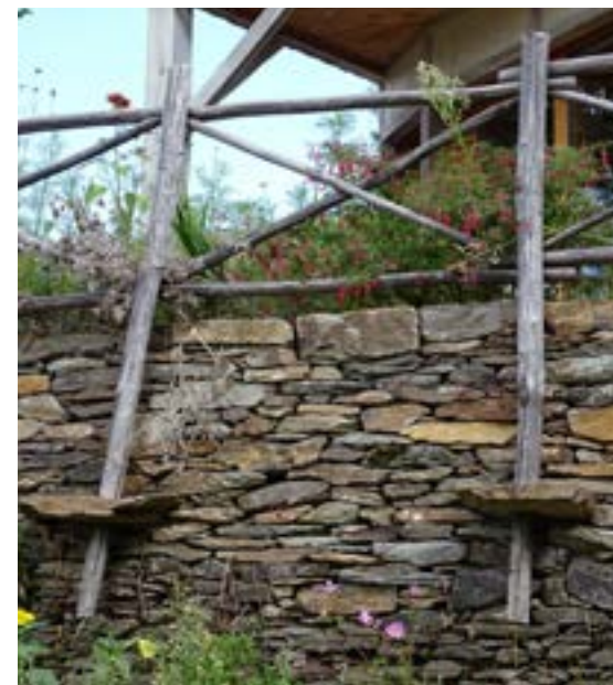
Garde-corps en perche de châtaignier ; possibilité de remplissage par résille
