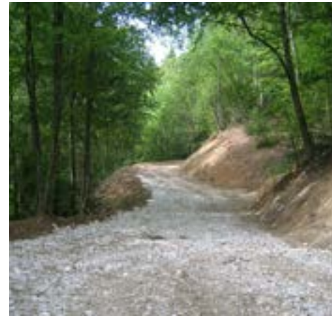
Bon exemple de route forestière à camions Source : CRPF
