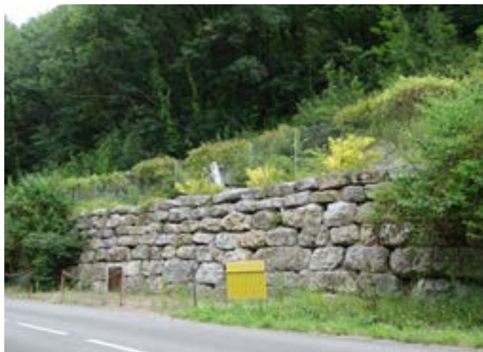
Station d'épuration, paroi en enrochements banalisante
