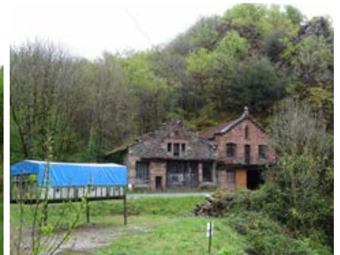
Zone de stationnement et de stockage, entrée sud, au moulin de Sanhes, au niveau du pont à revaloriser
