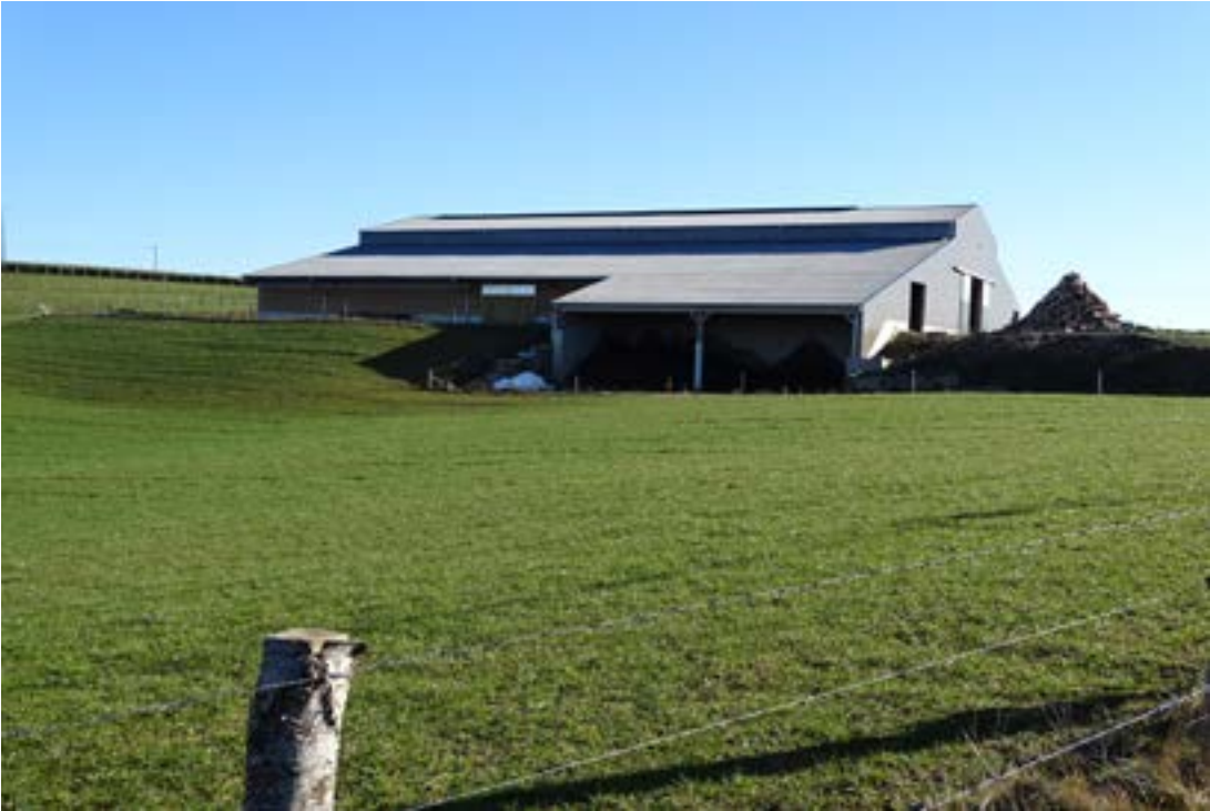
Très bonne adaptation du bâtiment à la pente du terrain naturel «à la manière» dont étaient implantés les bâtiments traditionnels. Exemple photographié dans le périmètre du projet Grand Site
