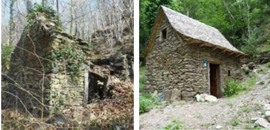
Exemple de restauration d'un sécadou avant/après © L.Campourcy Source : LPO Aveyron - réserve naturelle régionale « les coteaux du Fel »
