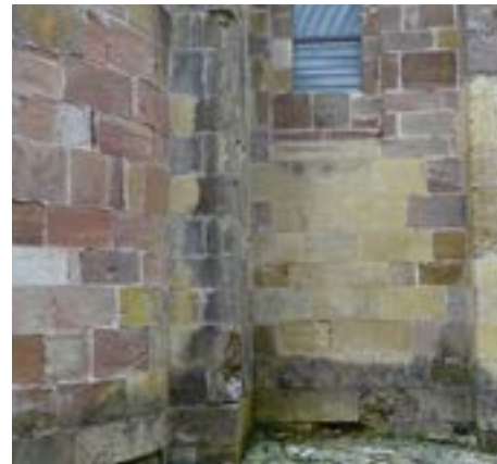
Fragment de l'élévation nord de l'abbatiale
