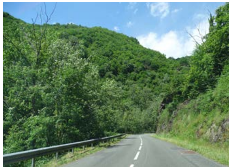
Une section avec glissière de sécurité à caractère routier
