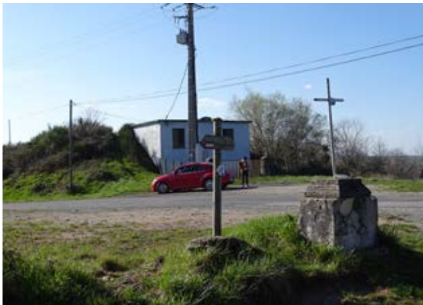
Château d'eau, réseaux aériens, zone de stationnement, croix de chemin, une accumulation sans qualité à l'approche de Conques.
